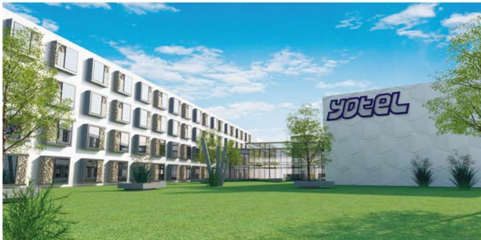
La façade du futur hôtel prévu à Etoy fin 2019 (image de synthèse). La résidence hôtelière comprendra 200 studios. DR
